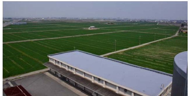
西部カントリーエレベーター上からの風景（4月上旬） 緑の部分が麦の栽培されている水田 6月上旬には一面が「麦秋」の小麦色となる
