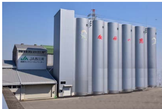
今年4月に竣工した西部カントリーエレベーター
