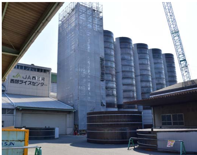
建設作業中のカントリーエレベーター（2月中旬）
