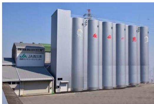
昨年4月に竣工した西部カントリーエレベーター
