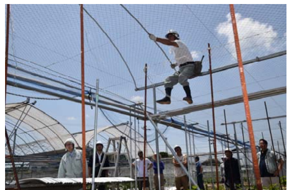
雨除けハウスの自家施工研修 足場の上でハウスの鉄骨を組む（2018年8月）
